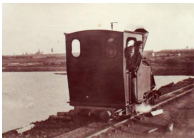
Узкоколейный паровоз («кукушка»), возивший дрова от «мыса» в завод. 1900 г.
