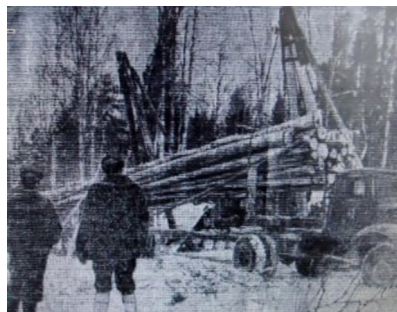
Погрузка хлыстов трактором-краном. Рассоленко
